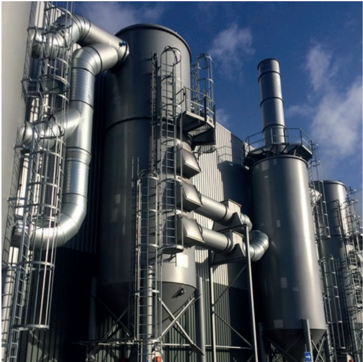
Scheidingsinstallatie AEB Amsterdam
